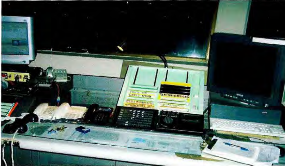
Dificultad de visibilidad por reflejo de las luces de techo en los vidrios de la torre.
